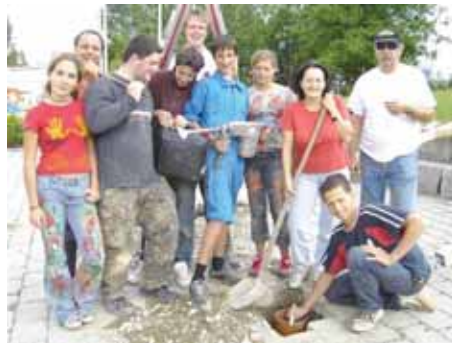
Schüler/innen stellen ihr handwerkliches Können beim Bau eines Pavillons im Schulhof unter Beweis.
