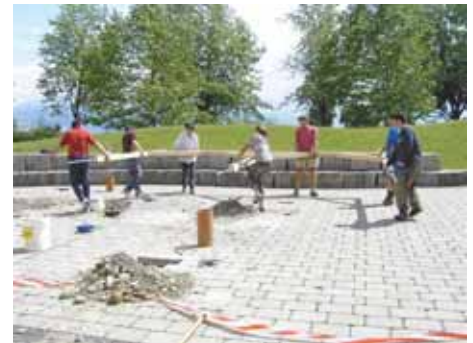
Zusammen wird das Gerüst des Pavillons aufgestellt.
