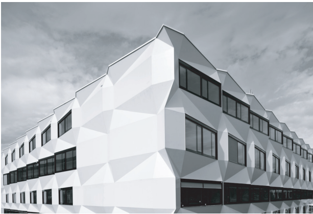
Abbildung 1: Luzern, UNI/PHZ-Gebäude, Fassadenausschnitt (Foto: Kanton Luzern, Dienststelle Immobilien)
