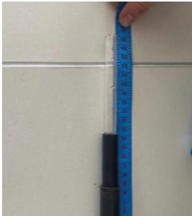
Abbildung 19: Verschachteln der Rohre für den Siphon
