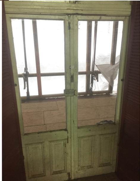
Blendrahmen wurde vermutlich schon einmal ausgetauscht, da dieser nicht die Profilierung des original vorhandenen Blendrahmens aus dem Raum EG 02 aufweist. Die Fenstertür ist mit drei Fitschenbändern angeschlagen und wird durch eine Drehstangenverriegelung verschlossen. Das Oberlicht hängt an zwei Fitschenbändern und wird durch zwei Drehriegel verschlossen.
