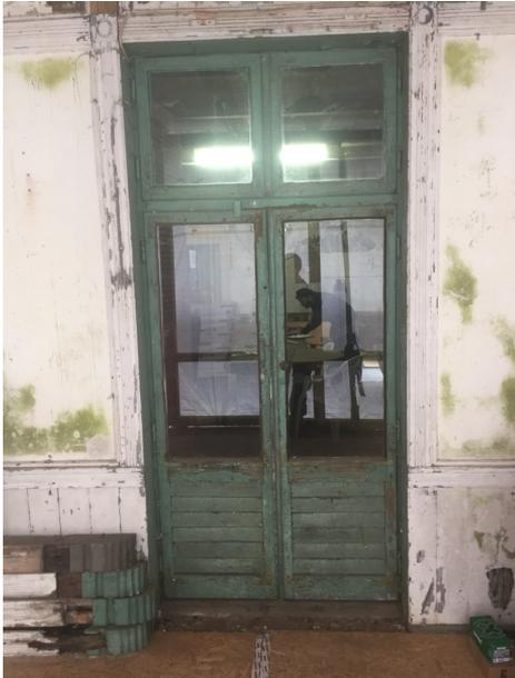
Die Aufteilung der Fenstertür ist eine 2:1 Teilung von Glas zu Füllungselementen. Von innen gesehen bestehen die, durch ein mittleres Setzholz geteilten, Füllungen aus einer abgeplatteten Vollholzfüllung. Von der Veranda aus wurde die Füllung durch eine gleichmäßige Lamellenteilung ersetzt, welche schräg in die aufrechten Flügelrahmen genagelt wurden. Alle Rahmenteile des Flügel- und Blendrahmens, sind durch Schlitz und Zapfen miteinander verbunden. Zur Stabilisierung
