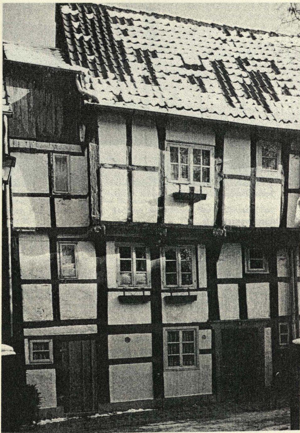
Abb. 3: Tropfhaus (Vorderseite an der Straße); Detmold, Adolfstraße 9 (ca. 1630 errichtet mit späterem schmalem Anbau, links)
