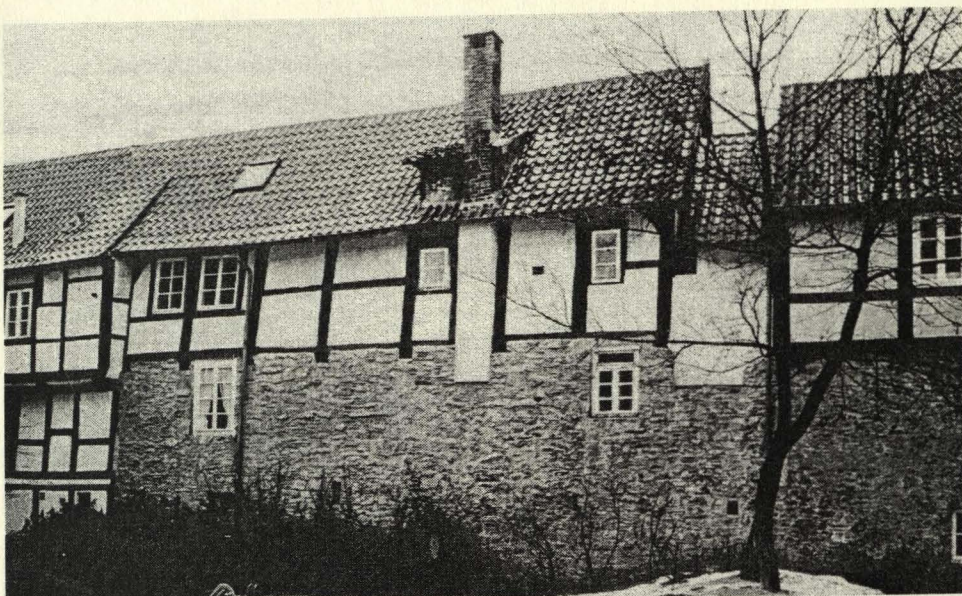
Abb. 4: Tropfhaus (Rückseite an der Stadtmauer); Detmold, Adolfstraße 9
