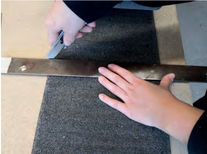
Abbildung 6: Zuschneiden der Sperrbahn mit dem Teppichmesser und einem Metalllineal
