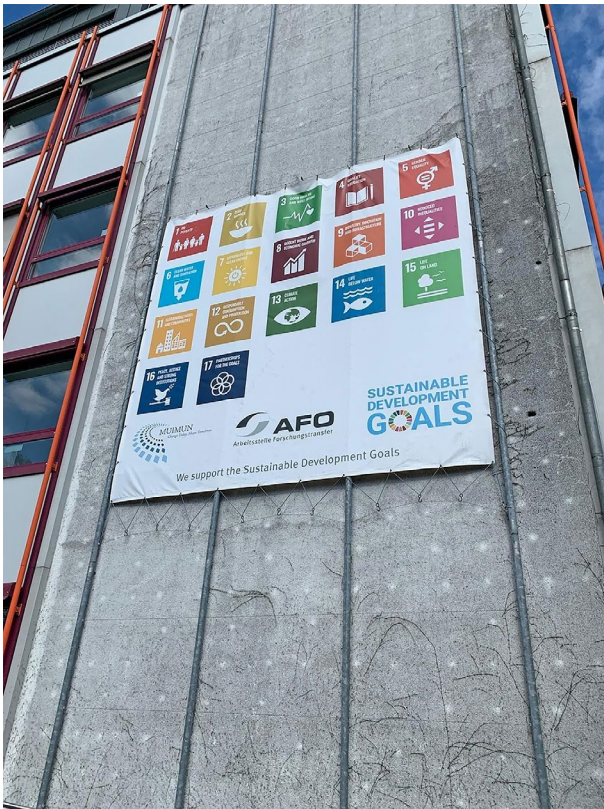
Abbildung 2: SDG-Icons an einer Hauswand
