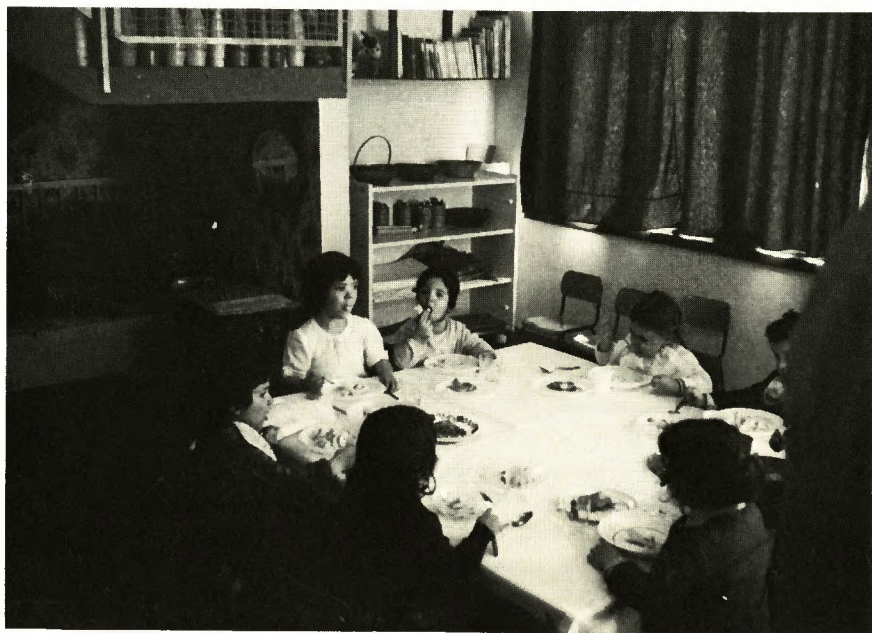
Ehemalige Kuhställe wurden zu Klassenräumen umgebaut
