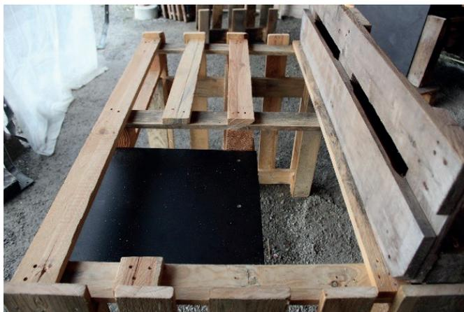
Abbildung 10: Versetzen der Holzlatten
