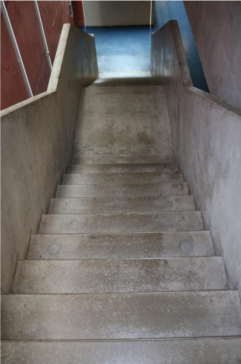
Abb. 5: Fehlende Kontraste oder Stufenmarkierungen in einem Campusgebäude
