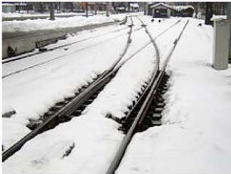
Abbildung 1: Weichenheizung, Quelle: https://de.wikipedia.org/wiki/Weichenheizung
