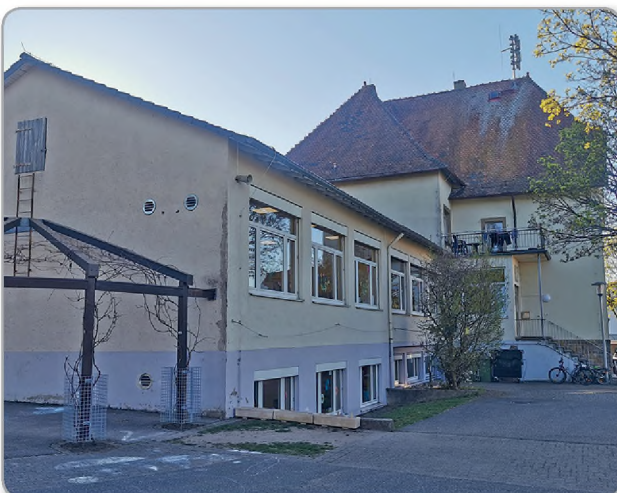
Abb. 1: Grundschule Rauental. Ein altes Schulgebäude mit moderner Pädagogik
